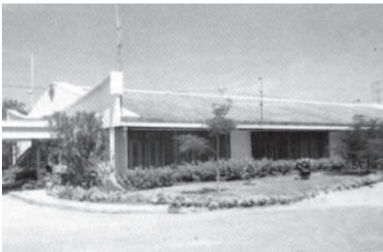
อาคารที่ทำการชั้นเดียวหลังเก่า
