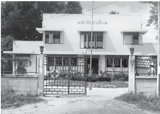
อาคารคอนกรีต ๒ ชั้น สร้างปี ๒๔๘๒
