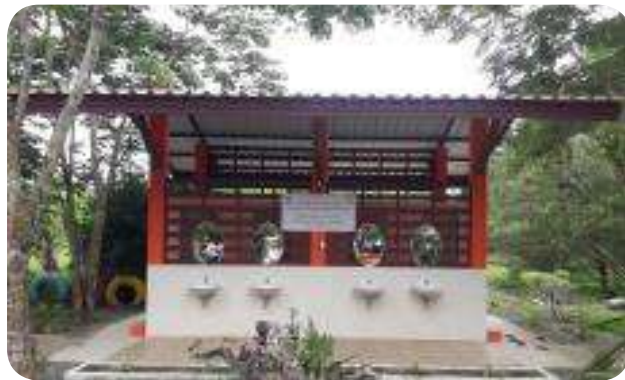
ห้องน้ำโรงเรียนบ้านห้วยแก้ว หมู่ 6 ตำบลพงศ์ประศาสน์ อำเภอบางสะพาน จังหวัดประจวบฯ Toilet at Ban Huaykaew School, Moo 6, Tambon Pongprasart in Bangsapan District, Prachuap Khiri Khun Province.
