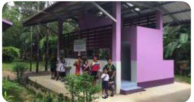
สร้างห้องน้ำโรงเรียนวัดวาลุการาม หมู่ 11 ตำบลแหลมทราย อำเภอลี้สวณ จังหวัดชุมพร Toilet construction at Wat Walukaram School, Moo 11, Tambon Laemsai in Lungsuan District of Chumphon Province.
