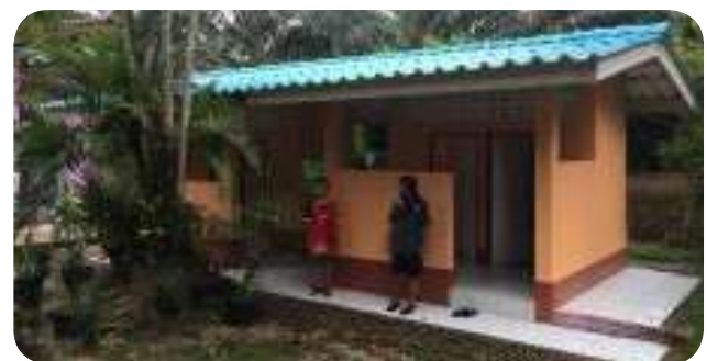
ซ่อมห้องน้ำโรงเรียนวัดวาลุการาม หมู่ 11 ตำบลแหลม ทราย อำเภอลี้สวณ จังหวัดชุมพร Toilet renovation at Wat Walukaram School, Moo 11, Tambon Leamsai in Lungsuan District of Chumphon Province.
